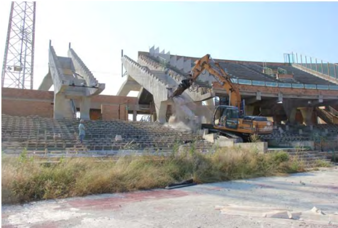
Demolizione trave
